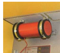
Löschgenerator
