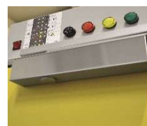
Steuereinheit mit Branddetektor
